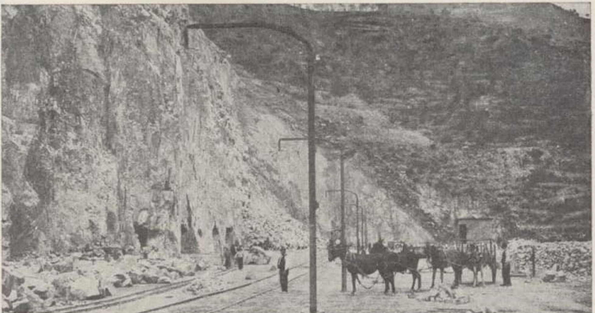
Fig. 2.—Cantera del Remedio en Caldas de Montbuy (Barcelona).
