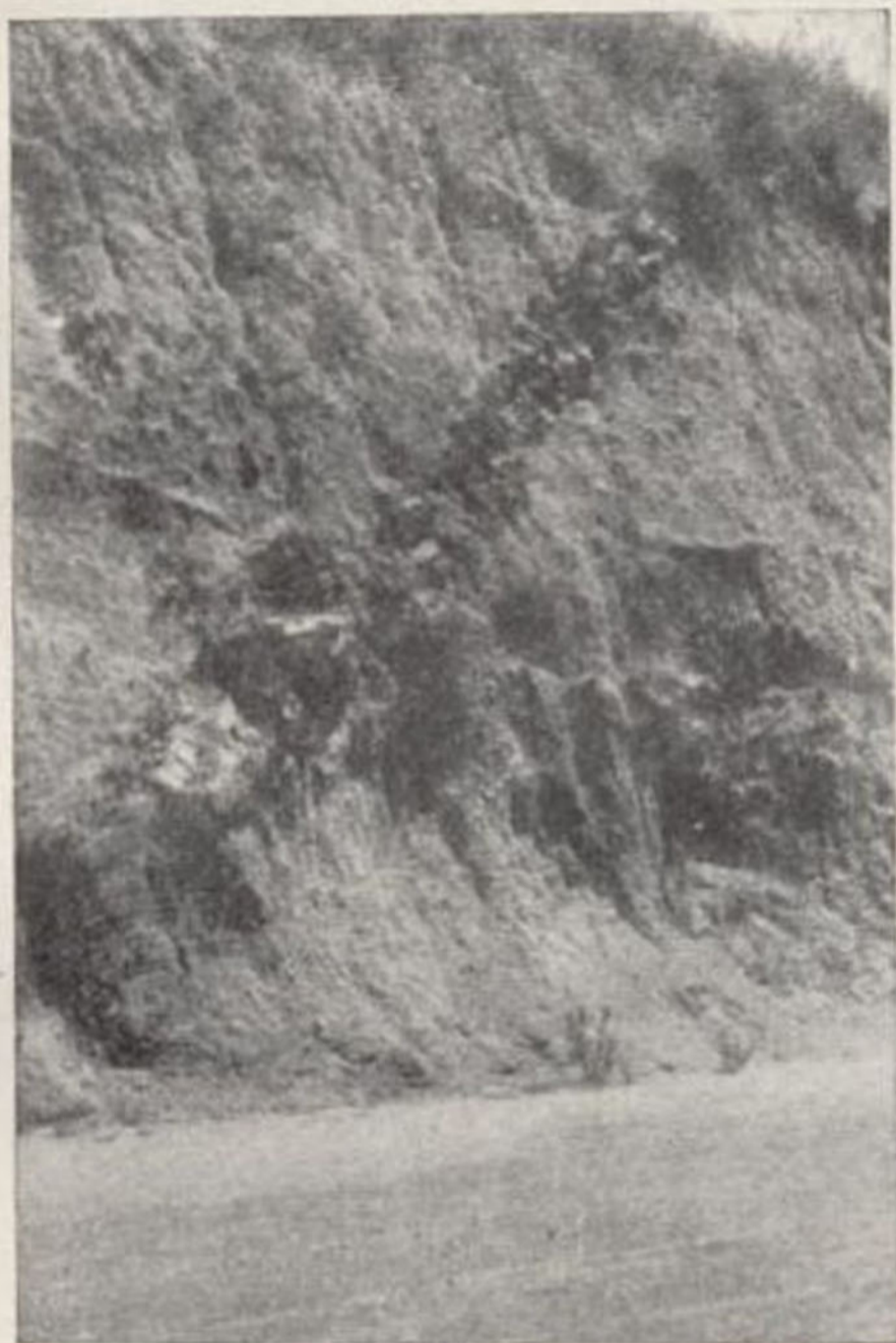
Fig. 36. – Dique de pórfido diorítico de 0,50 metros de espesor en el kilómetro 3, hectómetro 3, de la carretera de Orrius.
