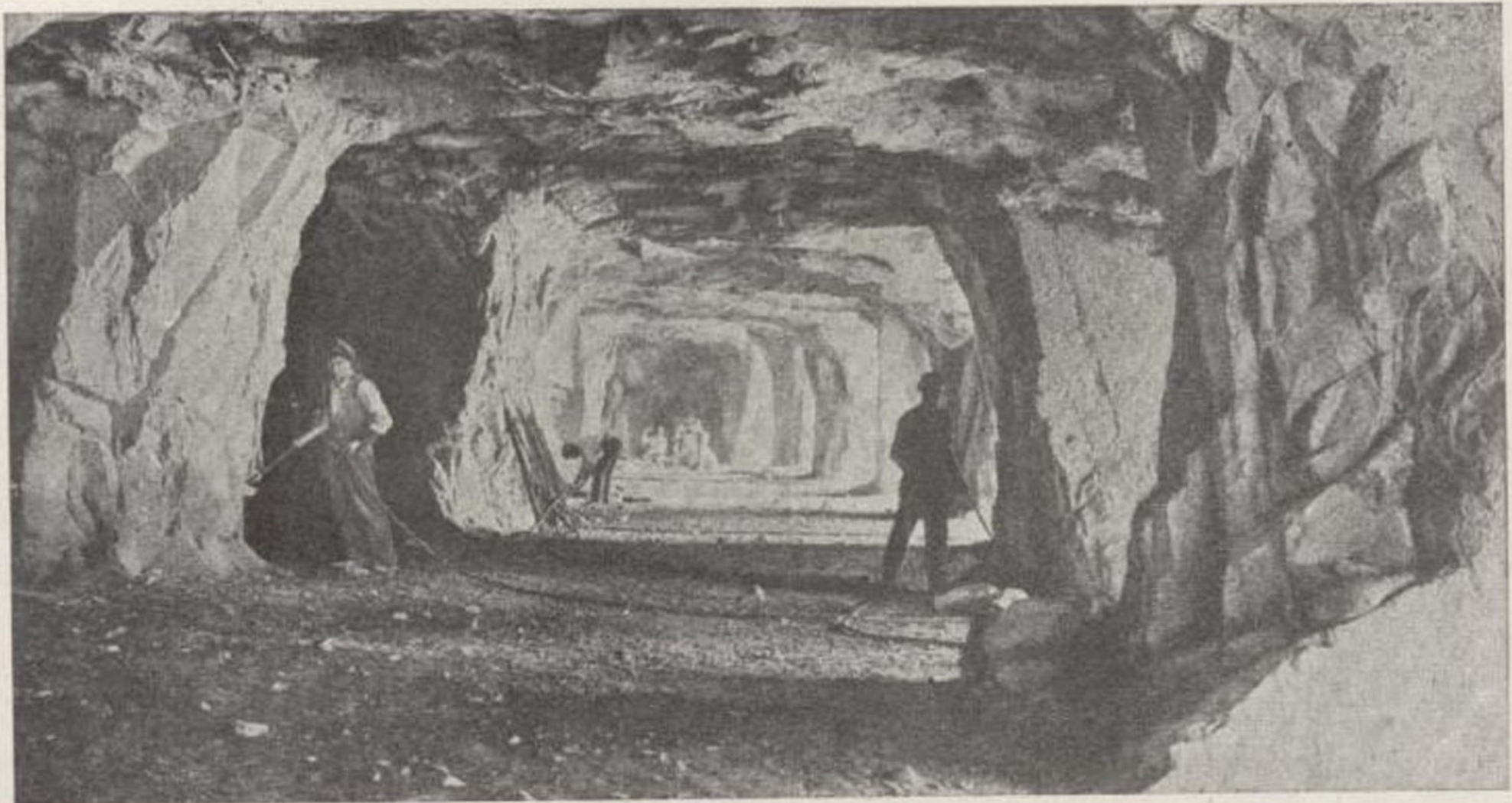
Fig. 4.—Cantera del Remedio en Caldas de Montbuy (Barcelona). Primera galería de la mina para el «enderroch»
